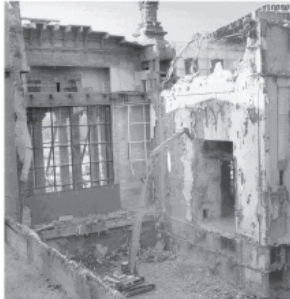
Bild 3: Abbruch der Westkerne mittels Beton-Cracker bestückten Ausleger
