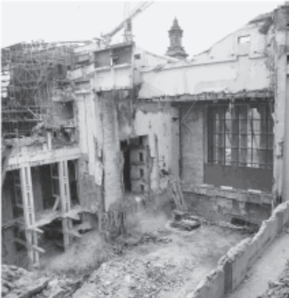
Bild 2: Zurückschneiden der Spannbetonscheiben mit Sauerstofflanze und Seilsäge
