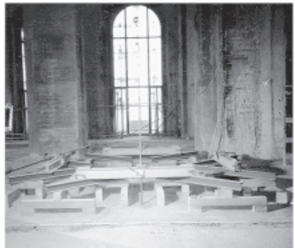
Bild 7: Lasteinleitung über Zugstangen von oben auf die jeweiligen Gewölbeviertel
