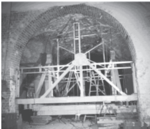
Bild 6: Belastungs- und Messeinrichtung für Lasttest an brandgeschädigtem Gebäude
