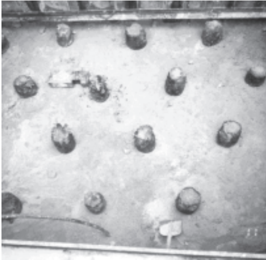
Bild 10: Freigelegte Holzpfählköpfe im Zentralbereich
