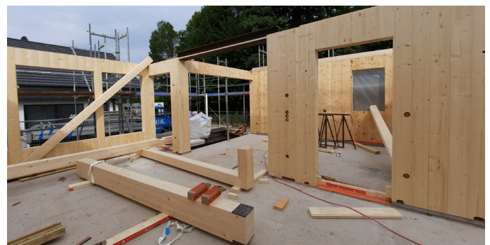
Abb. 2: Das Verfahren der holzius GmbH: Massivholzsysteme ohne Leim- und Metallverbindungen. (©IBS Bau-Statik PartG Schnizler & von Seggern mbB)
