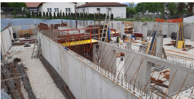
Abb. 1: Nur die Tiefgarage und der Erschließungskern sind in Stahlbetonbauweise ausgeführt. (©IBS Bau-Statik PartG Schnizler & von Seggern mbB)
